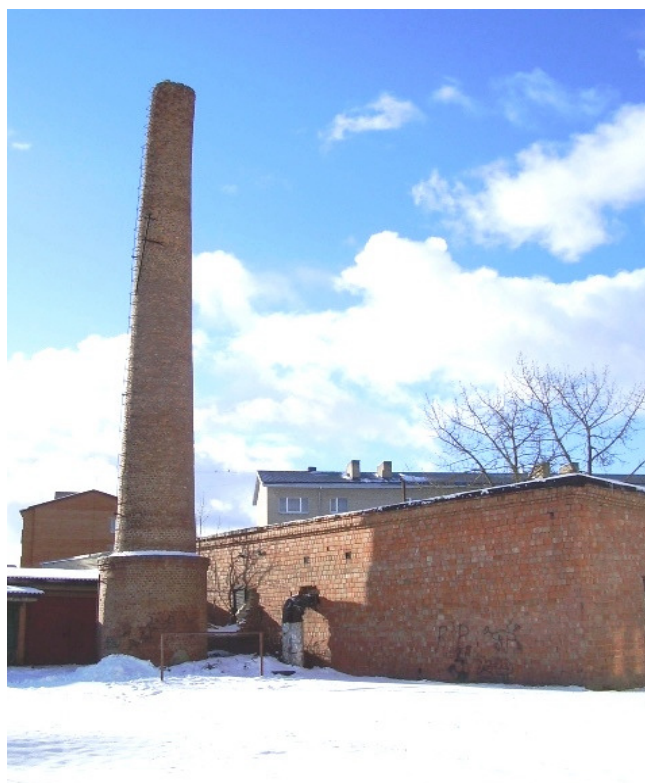
Vana katlamaja mis toimib soojusvõrgu jaotuspunktina
